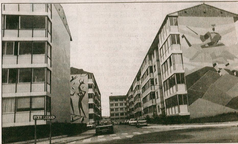
Los barcos en el puerto sirven de excusa para revestir las fachadas, de diez metros por quince. (Foto Carlos Villagrán)
